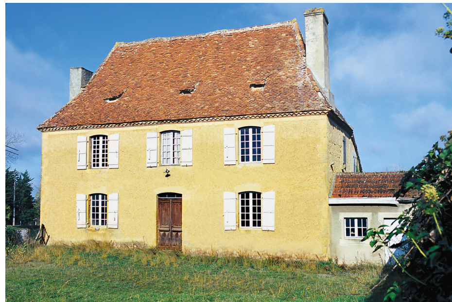
▲ La composition de la façade principale marque une symétrie rigoureuse.
