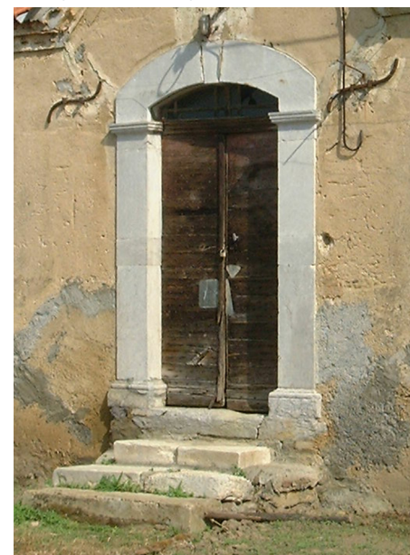
▼ Encadrement en pierre de taille. Enquadrament de pèira de talha.
