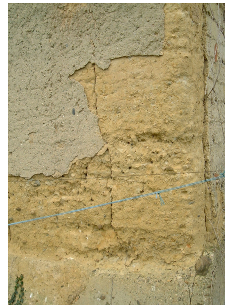
▲ Mur en pisé, protégé par un enduit à la chaux. Muralha en tàpia, protegit per ua capa de caucea.
